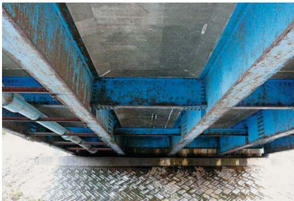
H形鋼桁橋上部工下面
