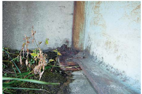
H形鋼桁橋支承部
