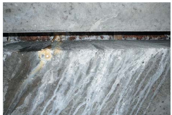
PC 中空床版橋間詰め部
